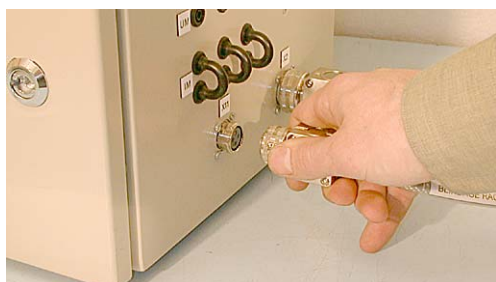
Connexion du moteur au variateur de vitesse
